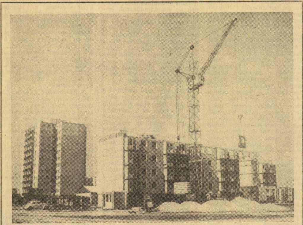
Százötven lakás építését vállalta Mosonmagyaróváron a Győr megyei Állami Építőipari Vállalat Szalay László panelszerelő-brigádja. A héten elkészül az első negyvenöt lakásos ház. A többi százötven lakást előreláthatólag szeptember végére készítik el a vállalat dolgozói.
